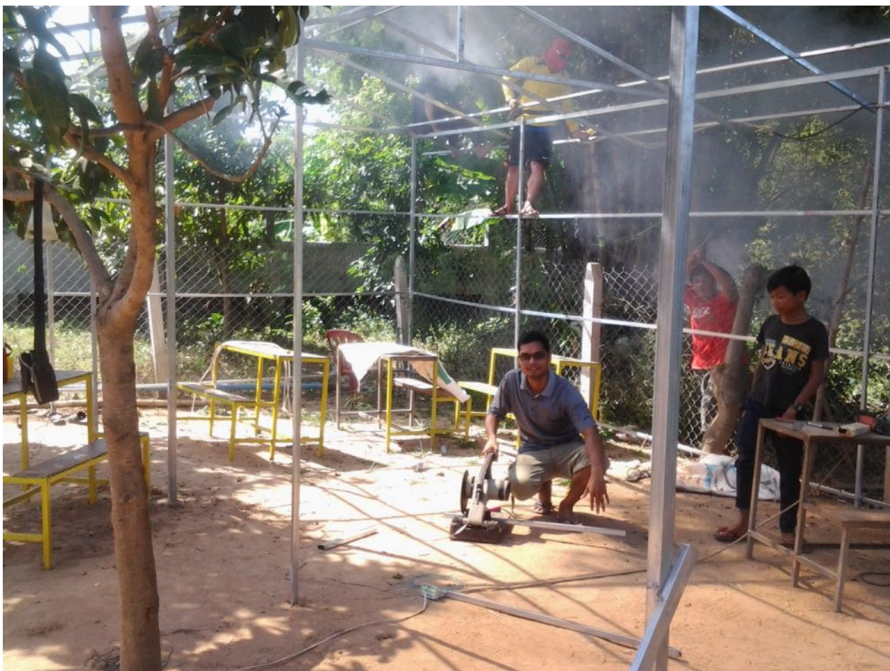
Construction d'une nouvelle classe en structure légère
